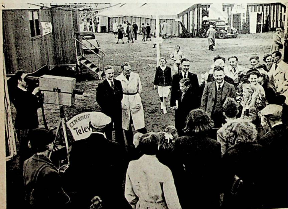
DE CAMERA IN ACTIE tijdens de Winthll-tentoonstelling. Camera-operateur: L. Foreman, PA 6 VT; de heer Havinga (staande naast de meisjes) als „zangpaedagoog”.
